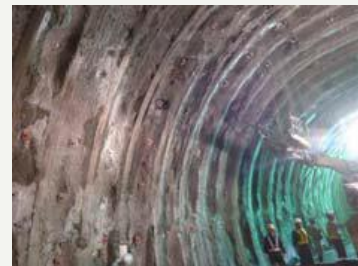
高高ボルト打設完了全景
