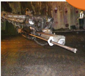
ドリルジャンボへの高高ボルト搭載状況
