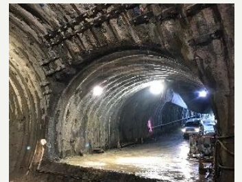
高高ボルトによる交差部補強事例
