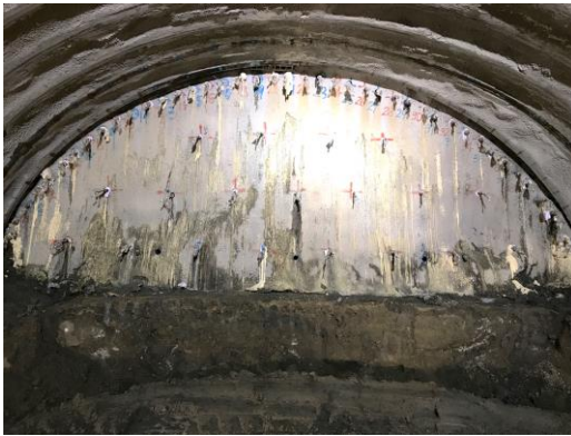
AGFタフタイトの打設完了状況
